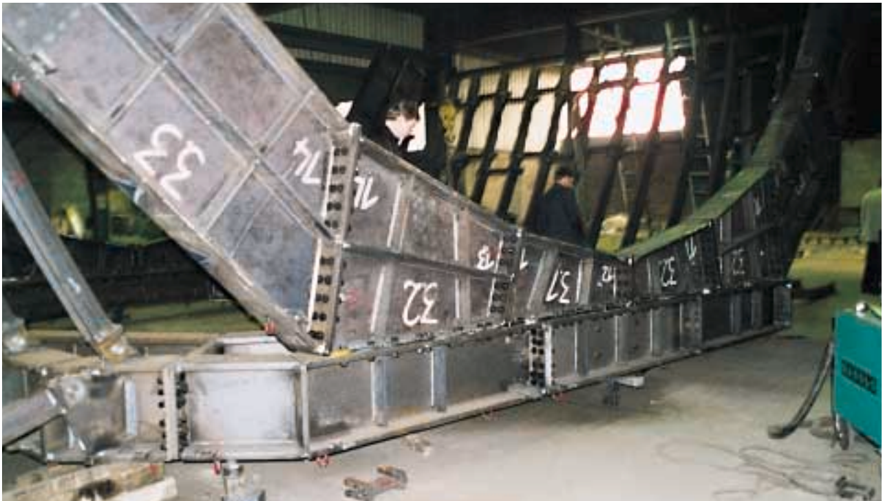
Kopfraumen, Polygon, Schachtglockenbaue in der Fertigungswerkstatt
