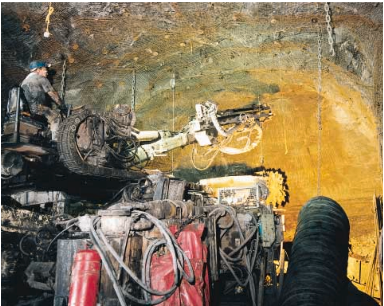
Vollankerung vor Ort
