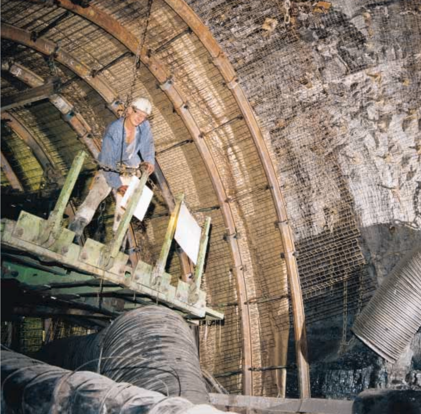
Der Unterstützungsausbaue wird ca. 25 – 30 m hinter der Ortsbrust eingebracht
